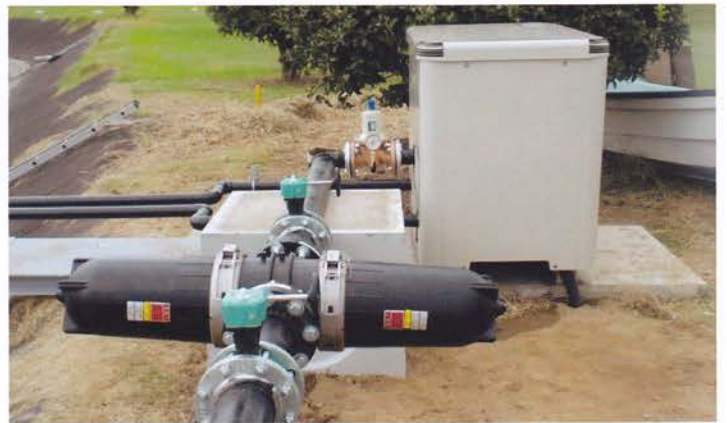
毎分 1300L ポンプ圧送管設置
