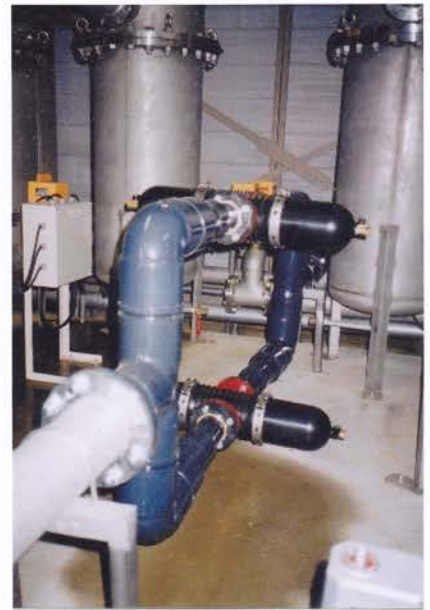
毎分 2000L ポンプ圧送管設置
