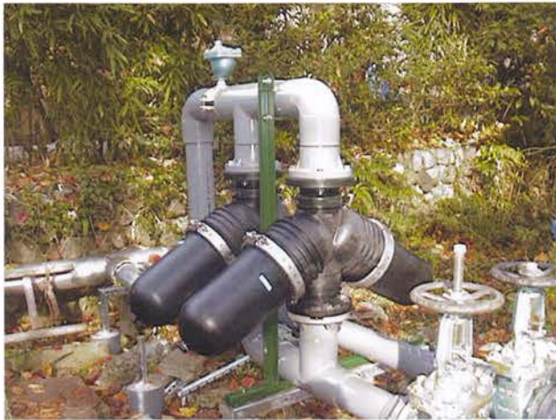
毎分 2600L ポンプ圧送管設置
